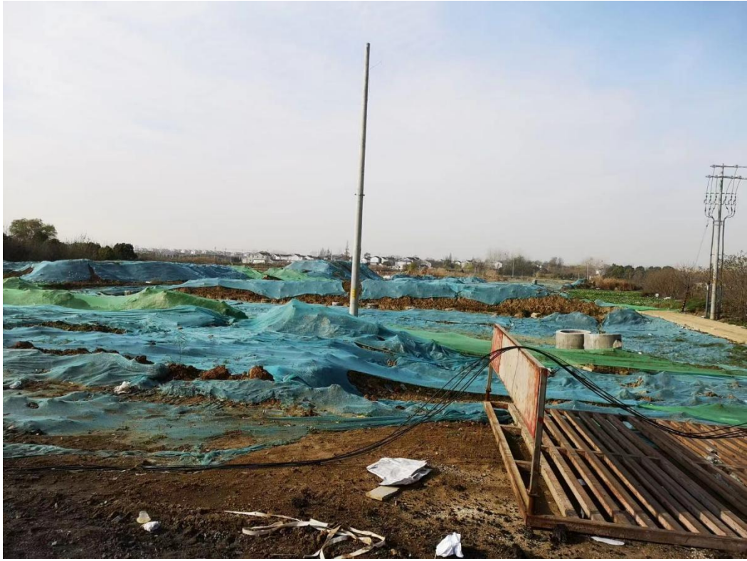
图 3.1 项目路段西侧用地情况
