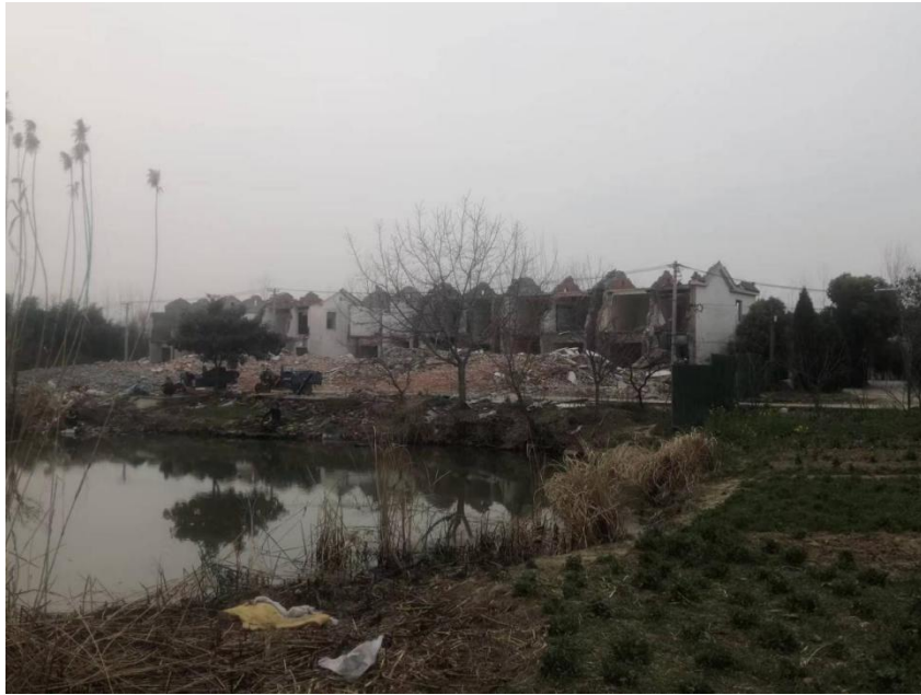
图 3.3 项目路段周边拆迁情况
